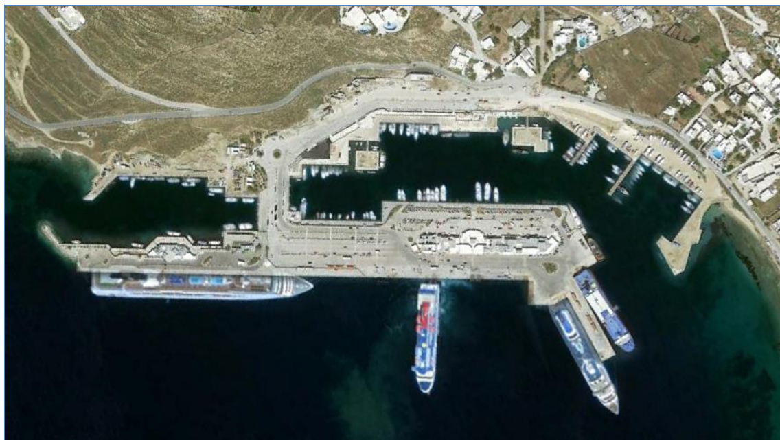
Σχήμα 6-67: Νέο λιμάνι στον όρμο Τούρλο (απόσπασμα από GoogleEarth 2018)
