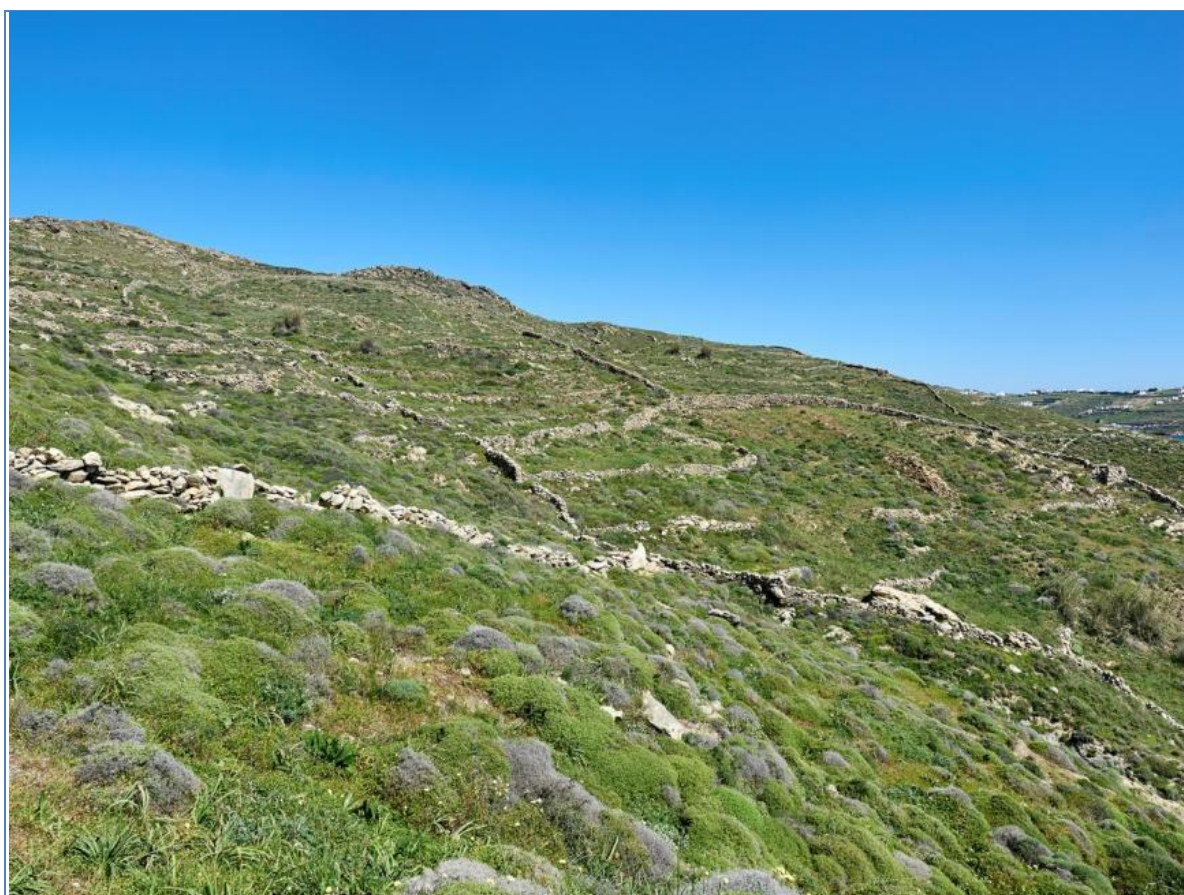
Φ5: Ανάπτυξη ξερολιθιών στο ακίνητο, με εμφανείς φθορές. Η λήψη έχει προσανατολισμό Ν→Β
