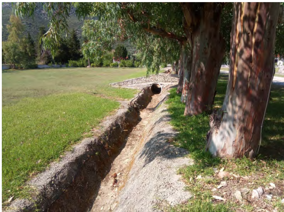
Φωτ.3.5. Άποψη της σημερινής τεχνητά διαμορφωμένης κοίτης , η οποία θα αντικατασταθεί με νέα διευθέτηση, δυτικότερα αυτής, σύμφωνα με την οικεία υδραυλική μελέτη.
