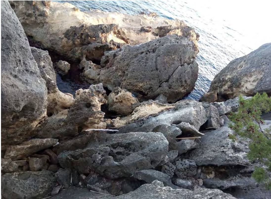
Φωτ.10. Άποψη βιοκλαστικών ασβεστιτικών ψαμμιτών, στο παράκτιο, ανατολικό τμήμα της χερσονήσου (εκτός ορίων ακινήτου).
