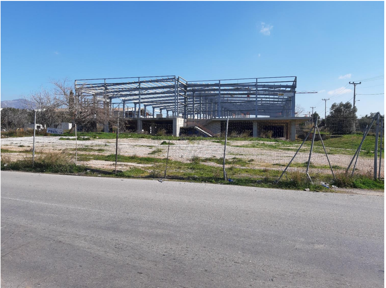
Φωτ. 1: Άποψη του γηπέδου της πολεοδομικής ενότητας Γ και του υλοποιημένου σκελετού δώροφου κτιρίου από σιδηροκατασκευή (από την οδό Ερμού)
