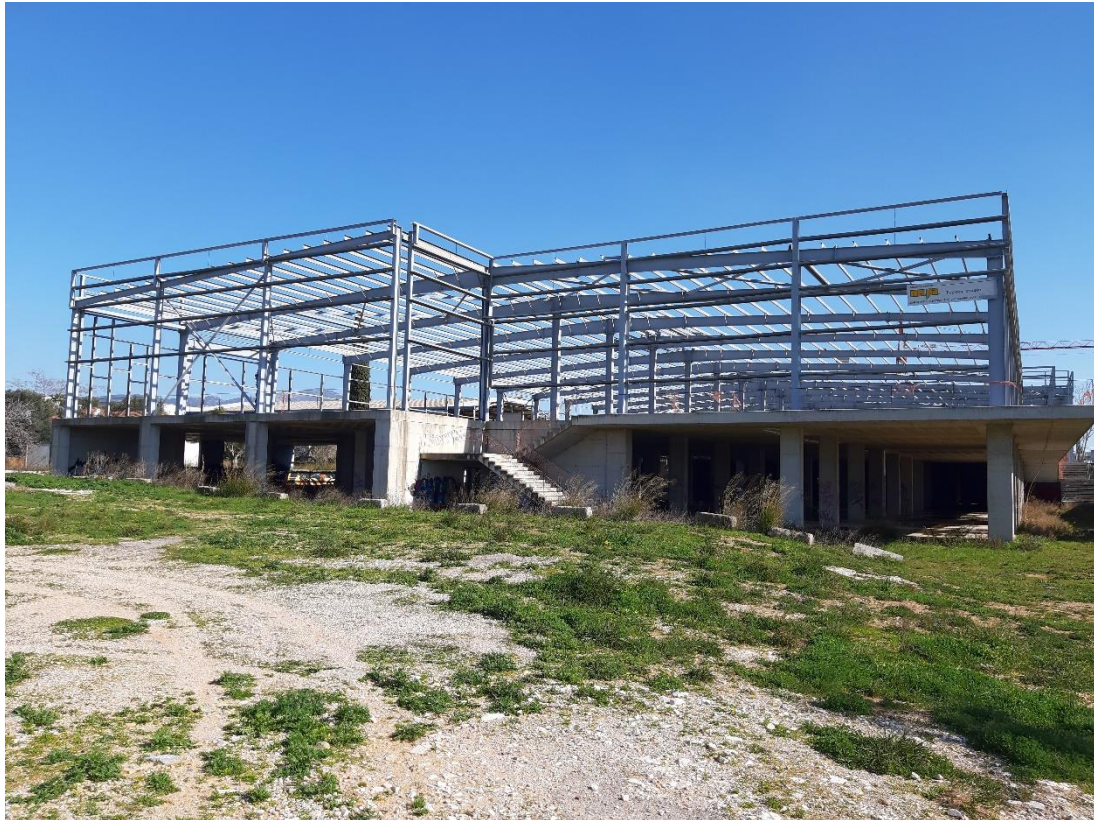
Φωτ. 6: Κοντινή άποψη του υλοποιημένου στην ενότητα Γ σκελετού διώροφου κτιρίου από σιδηροκατασκευή
