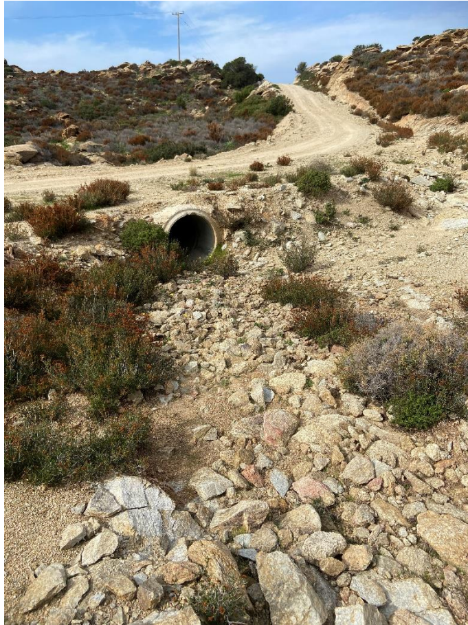
Φ17 Τεχνικό (πλακοσκεπής οχετός) στη διασταύρωση του ρέματος 3 με τον χωματόδρομο.
