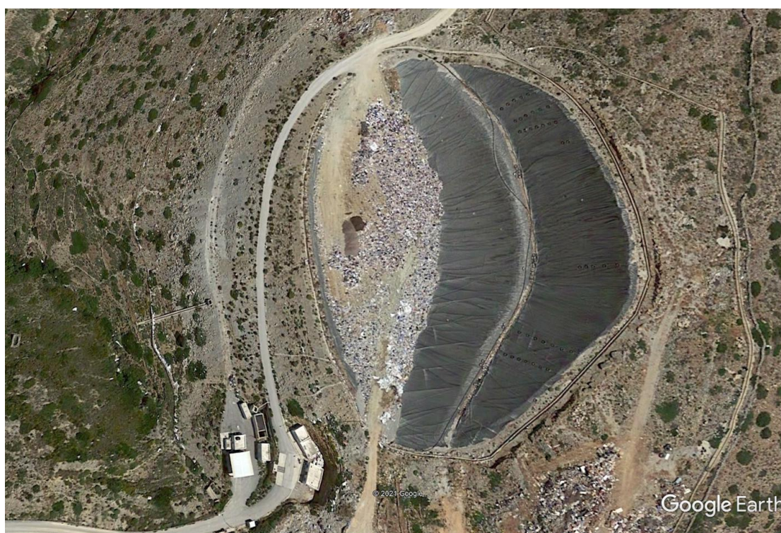
Εικόνα 6.7-5 Ο δημοτικός ΧΥΤΑ, φαίνεται η μερική πλήρωσή του και η μεμβράνη στεγανοποίησης στο τμήμα που δεν έχει πληρωθεί ακόμη (από Google Map, 31/5/2019)
