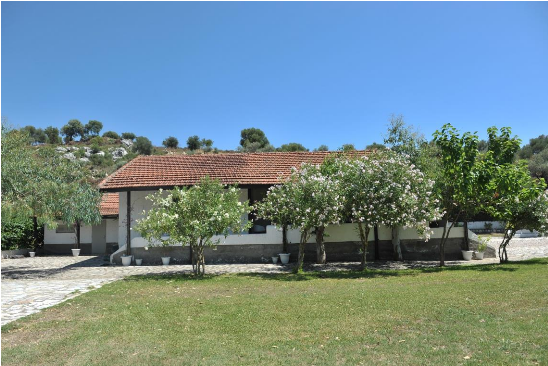
Εικόνα 4.1.5-2: Άποψη κατοικίας (Αρ. Άδειας 294/87) εντός του ακινήτου 7
