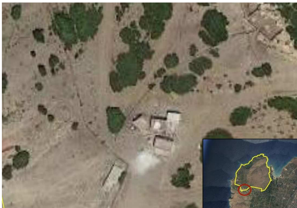
Εικόνα 5-3 Υφιστάμενα Κτίρια εντός της έκτασης του προτεινόμενου Ε.Σ.Χ.Α.Σ.Ε.
